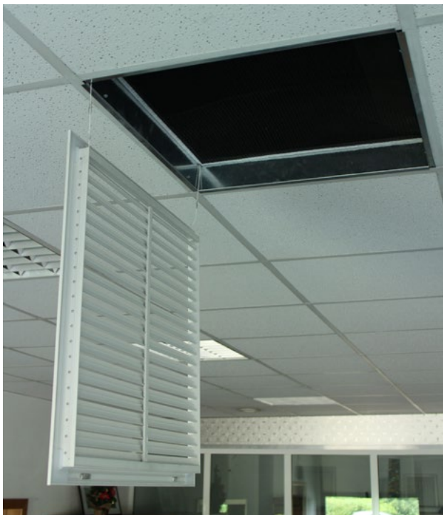
Particolare del fissaggio griglia ispezionabile GTF
