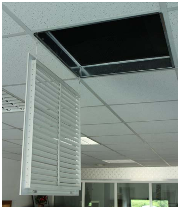
Particolare del fissaggio griglia ispezionabile GTF
