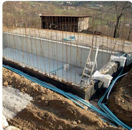
**Tubo spirale per gli impianti interrati in pressione di piscine e vasche idromassaggio, resistente al cloro, allo schiacciamento e al cracking.**
