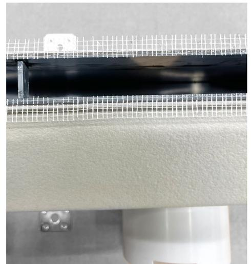
Due plenum/diffusori «LINE-S 23», uno da 1000mm-Ø125 e uno da 500mm-Ø75, completi dei relativi accessori (foto a sx) e particolare della bocca con retina per la rasatura (foto a dx). Entrambi sono stati verniciati di nero prima della posa (la parte interna dei «LINE-S» è verniciabile).
