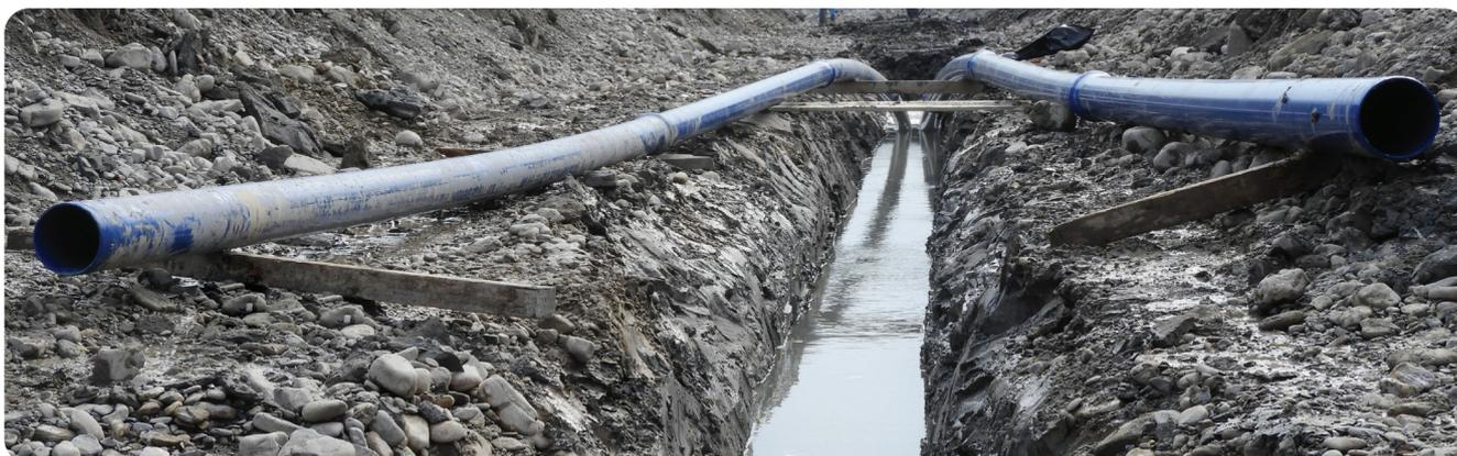
La tecnología **FITT Bluforce RJ** añade la resistencia a la tracción a las ya conocidas características de FITT Bluforce: en igualdad de diámetro exterior al sección hidráulica de **FITT Bluforce RJ** aporta mejoras respecto a otros termoplásticos normalmente utilizados para el transporte de agua potable a presión;
