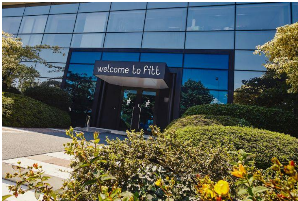
Figura 1 Sede centrale di FITT a Sandrigo
